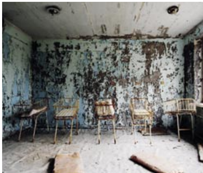
Die Plattenbausiedlung Pripjat , die nur drei Kilometer vom Reaktor entfernt lag, ist heute eine Geisterstadt.
